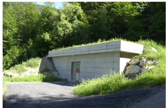
Réservoir et station de pompage/turbinage de Chenallettaz
