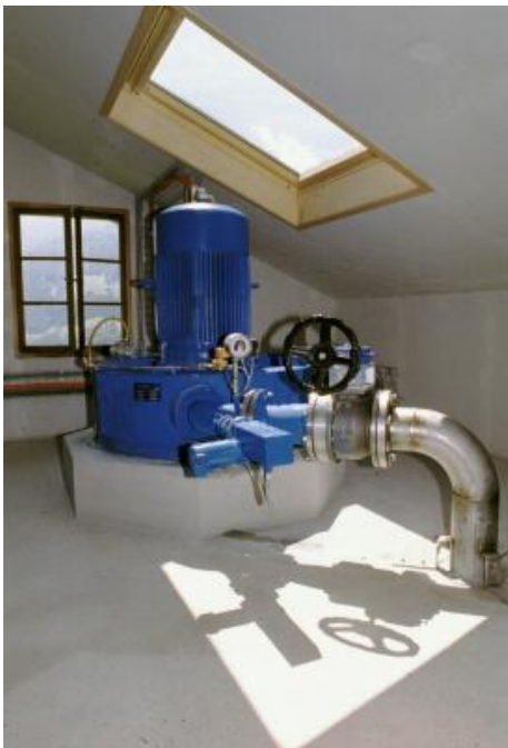
Groupe turbo-alternateur 75 kW
