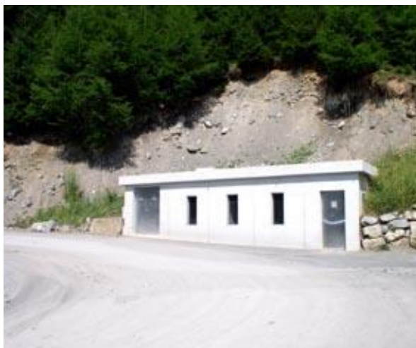
Extérieur du local de turbinage (source: commune de Savièse)
