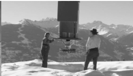
1 La Zour roue de la turbine 2 La Zour montage de l'alternateur
