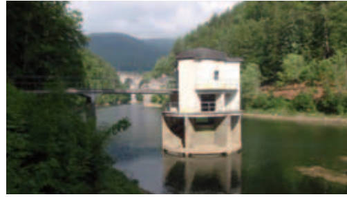
Barrage du Day
