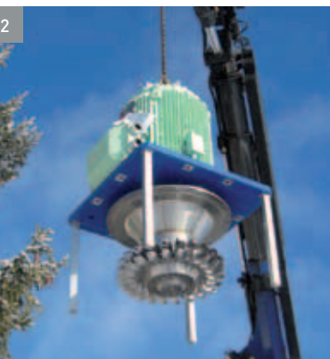
3 Saas Fee, CH, 33 l/s, 206 m, 55 kW, sur l'eau potable, turbine Pelton à contre-pression à deux injecteurs, Mhylab, Blue Water Power, 2010 (© Blue Water Power AG)
