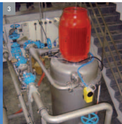
3 Saas Fee, CH, 33 l/s, 206 m, 55 kW, sur l'eau potable, turbine Pelton à contre-pression à deux injecteurs, Mhylab, Blue Water Power, 2010 (© Blue Water Power AG)
